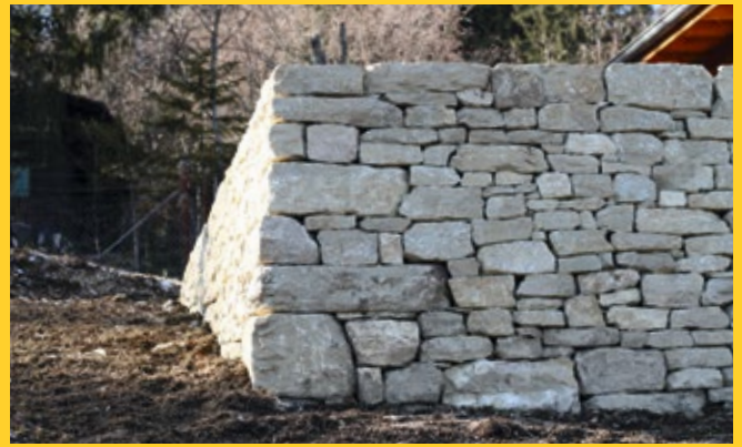
Terrassen-Stützmauer / Mur de soutènement de terrasse
